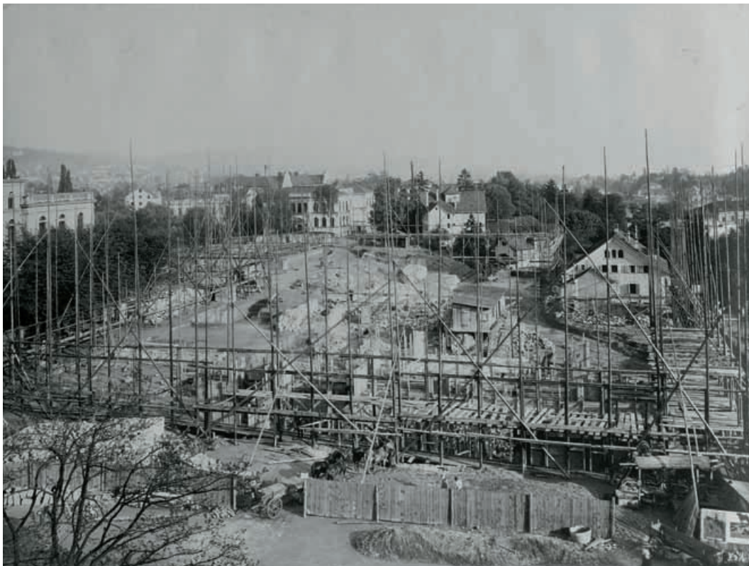
Ausgehobenes Baufeld: Der Spatenstich für den Bau des Hauptgebäudes der Universität Zürich erfolgte am 3. Januar 1911.
