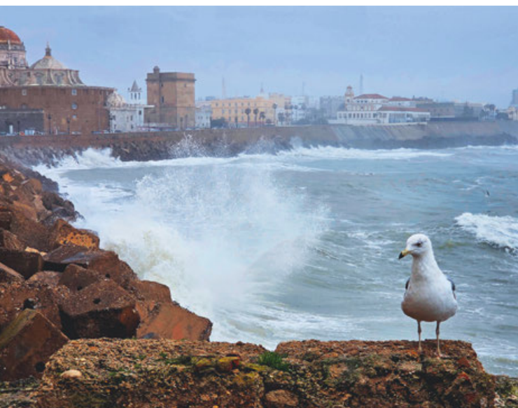
Cádiz, Spanien: Grosse Wellen brechen an der Uferbefestigung.
