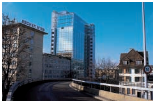
Abb. 1: Mobimo-Hochhaus: umstrittene Umgestaltung des ehemaligen Sulzer-Hochhauses.
